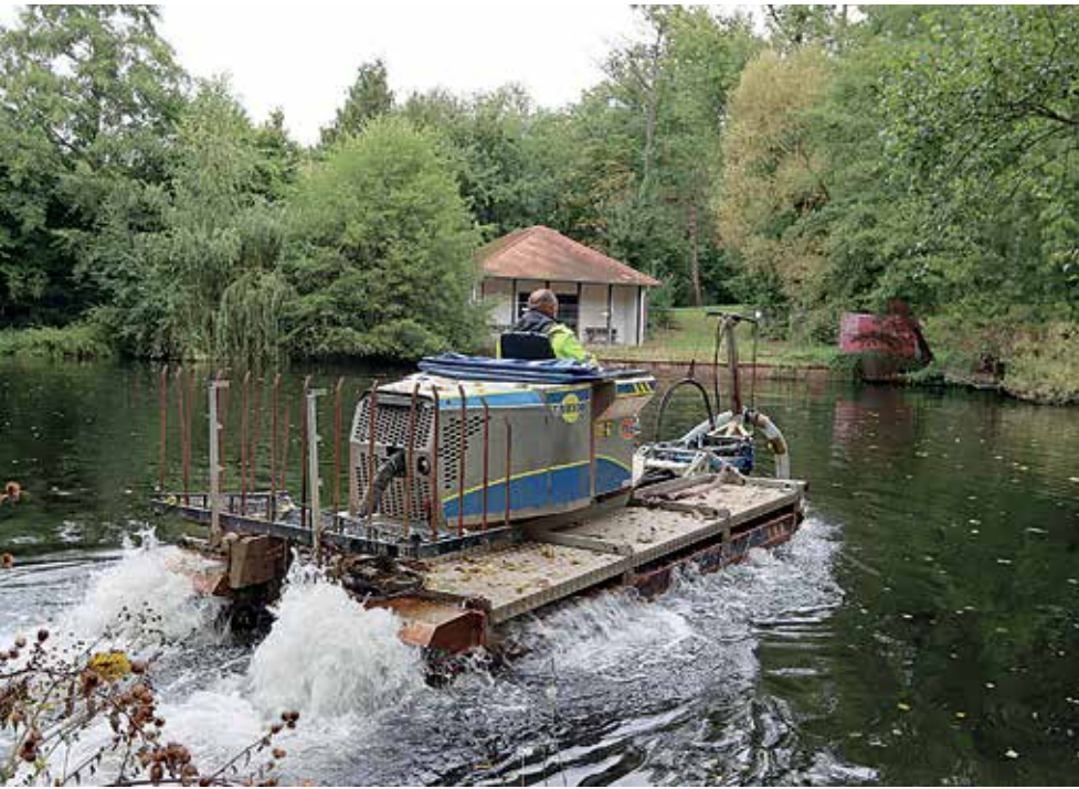
Mit einem Spezialboot wird der Saugschlauch für die Entschlammung im Paddelteich bewegt. Foto: Dexheimer/Stadt Langen
